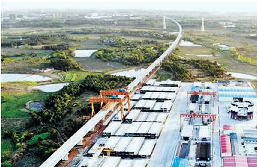
合安高铁桐城北制梁场箱梁预制完成
